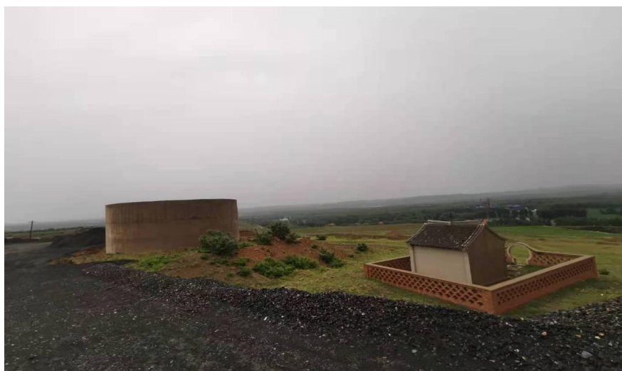
照片4-7 高位水池
