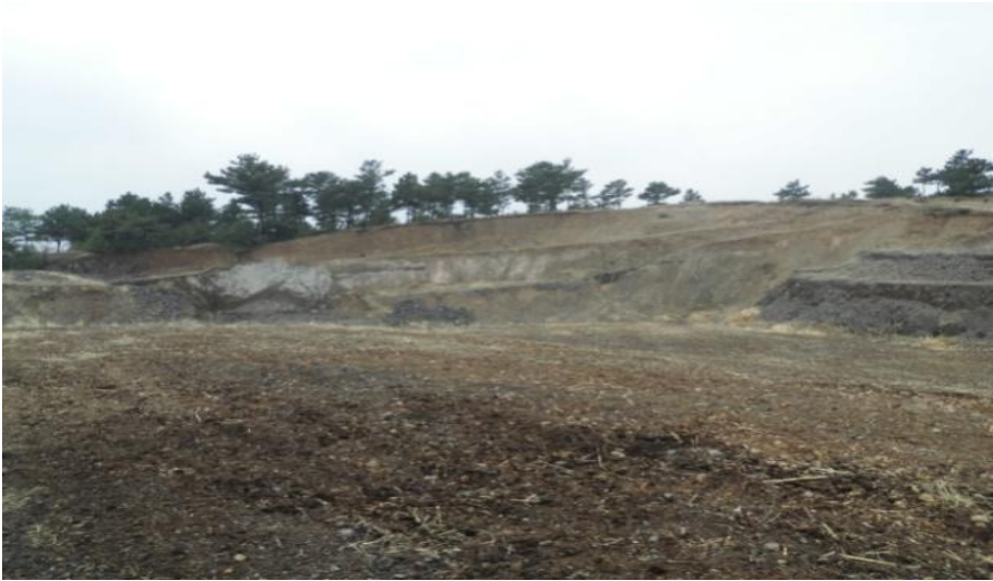
照片2-1 削坡、平整、覆土
