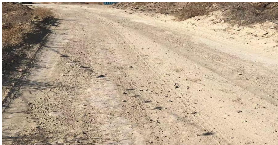
照片 4-3 矿区道路
