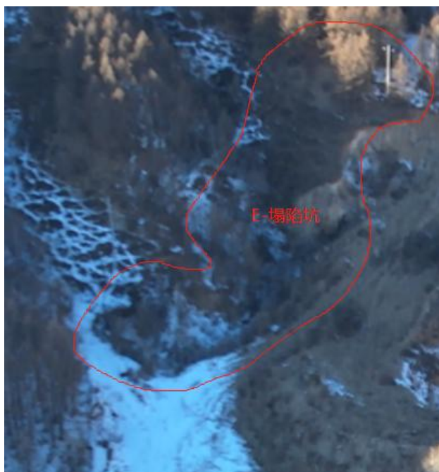
照片 1-9 E-民采塌陷坑
