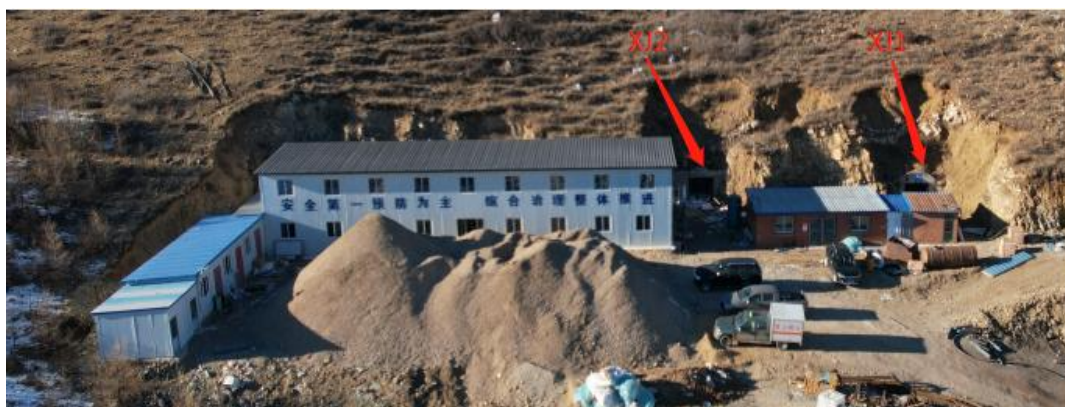
照片 1-1 斜井工业场地
