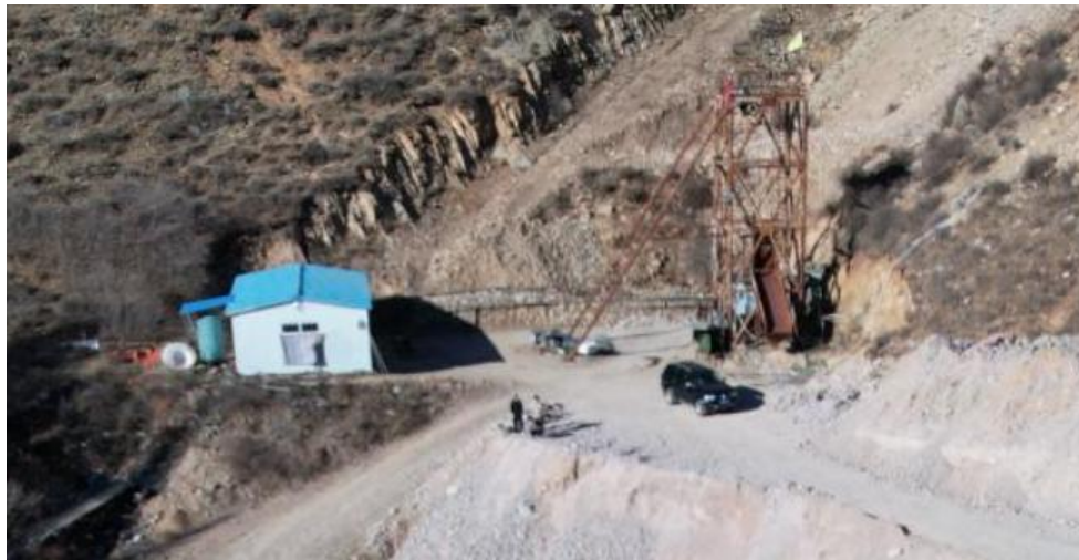
照片 1-12 竖井工业场地
