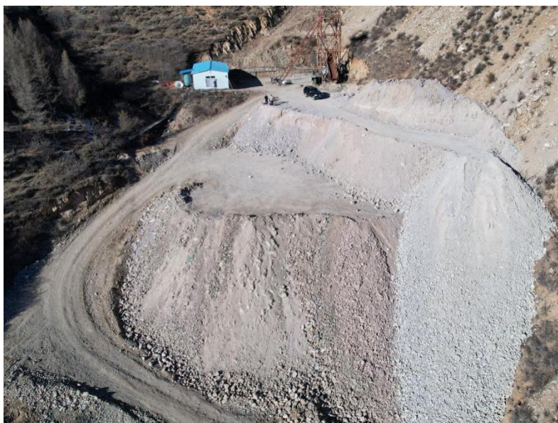
照片 1-13 竖井废石场
