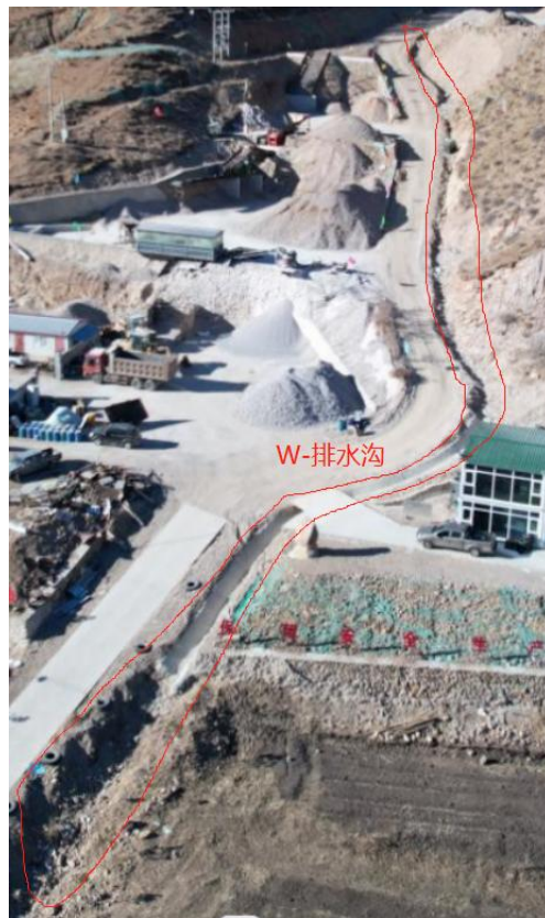
照片 1-26 W-排水沟
