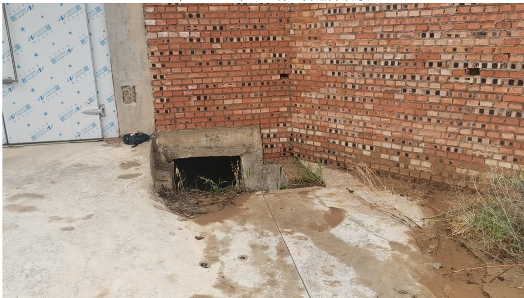
照片 3-9 2 号工业场地内仓库出水口
