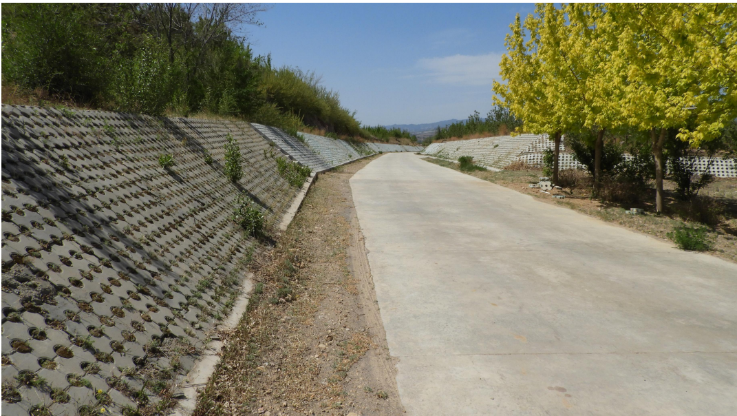
照片 3-7 2 号工业场地（边坡治理及地面硬化）
