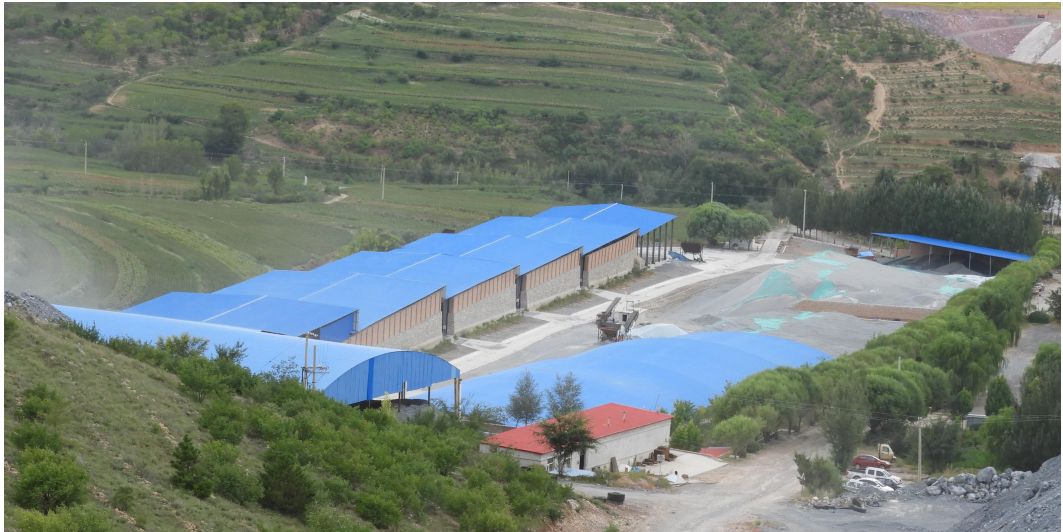
照片 3-4 1 号工业场地
