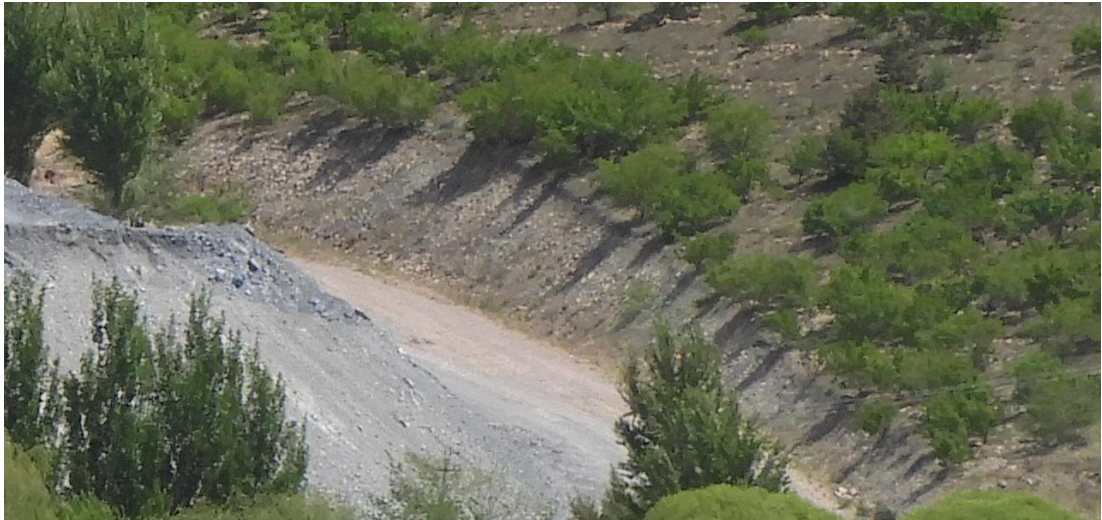
照片 3-19 矿区道路切坡(料堆 1 东侧)
