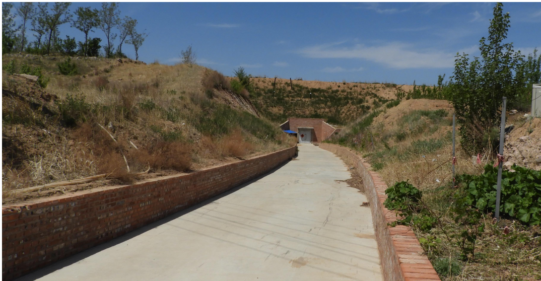
照片 3-8 2 号工业场地内仓库切坡
