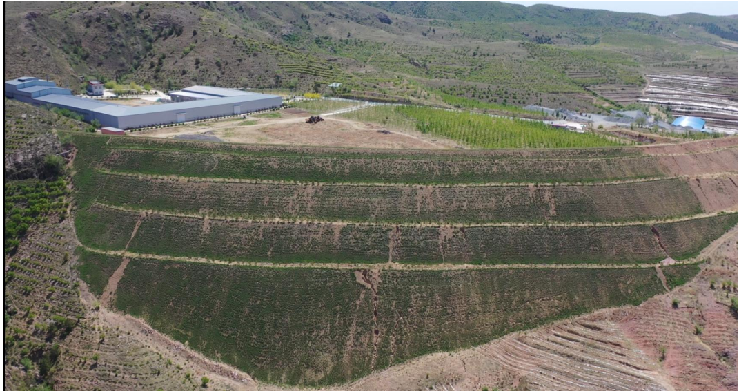
照片 3-6 2 号工业场地（整体）
