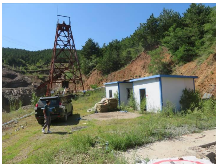
照片 3-9 竖井工业场地
