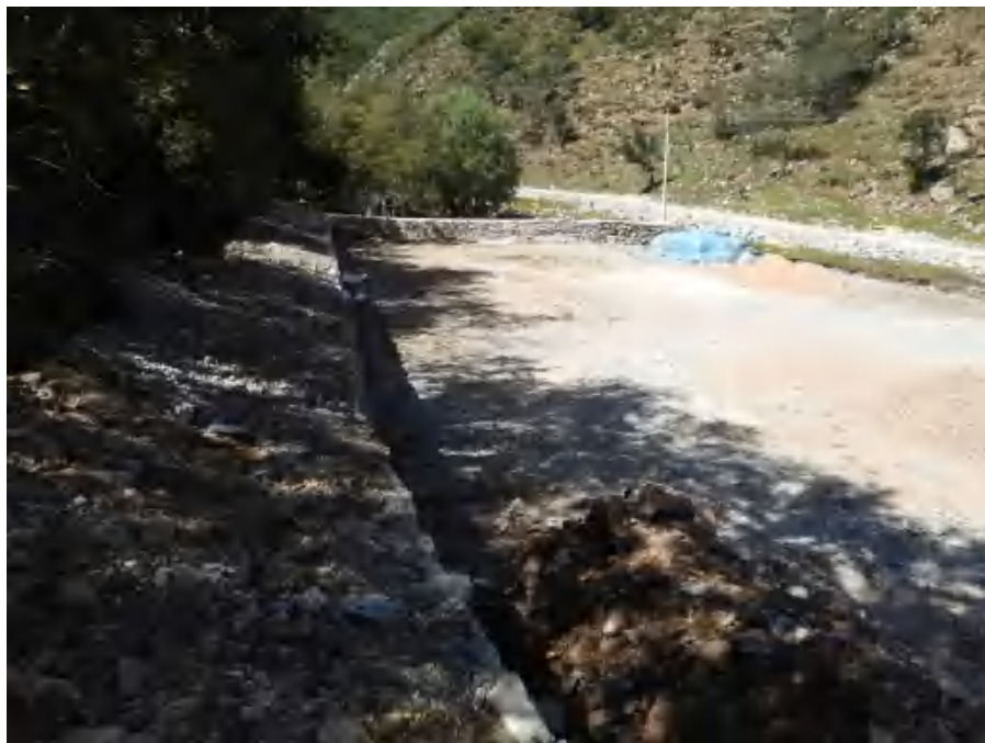
照片 4-2 废弃平硐工业场地设置浆砌石挡墙效果
