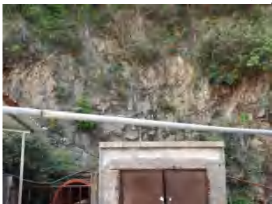
照片3-8 平硐（PD1）切坡挂网护坡
