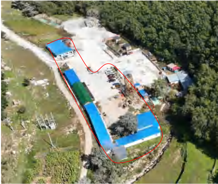
照片 3-1 竖井工业场地全景照片
