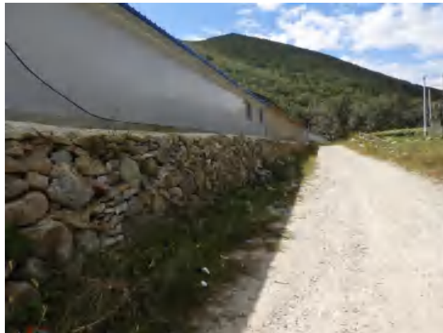
照片3-4 竖井工业场地周围砌石围护结构
