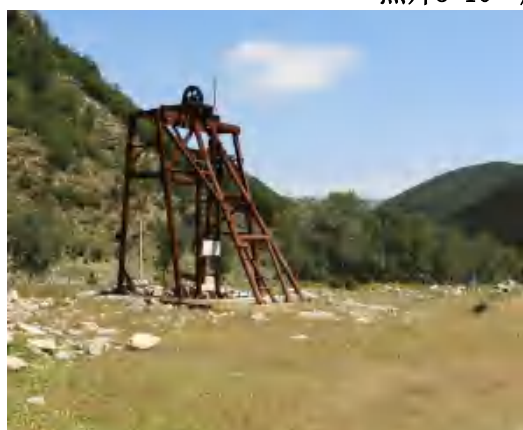
照片3-11 废弃竖井
