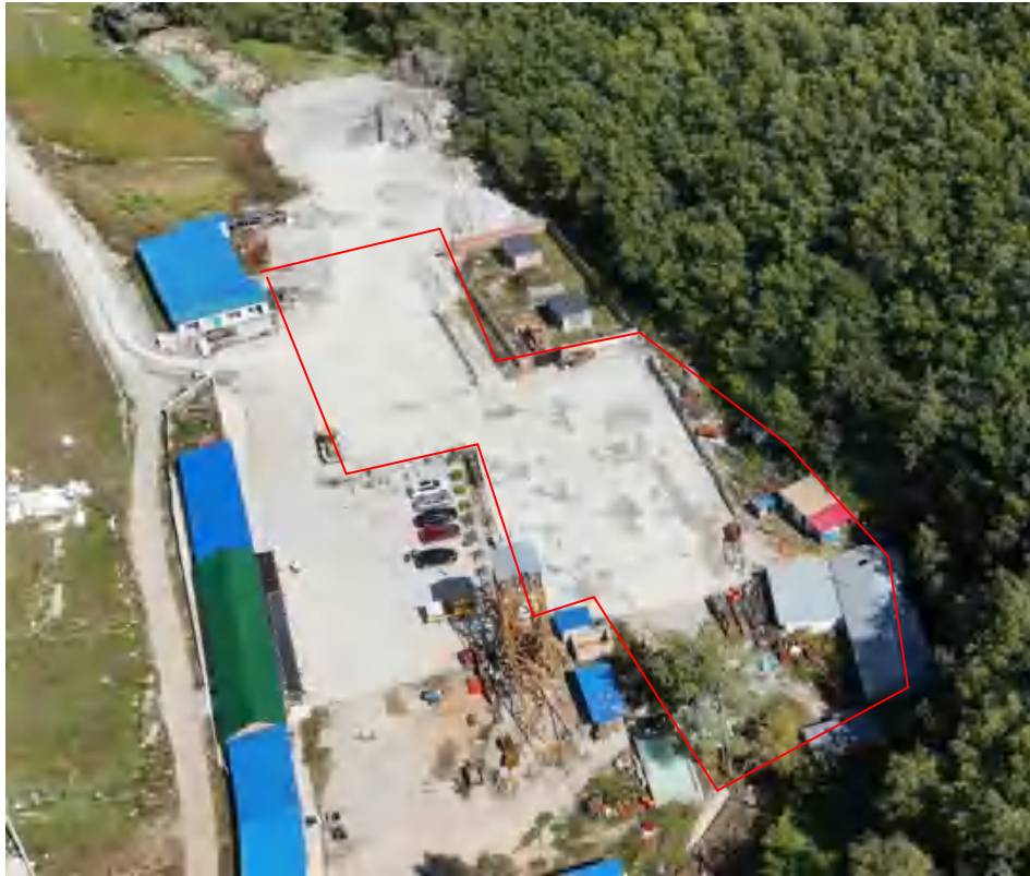
照片3-5 平硐工业场地全景照片
