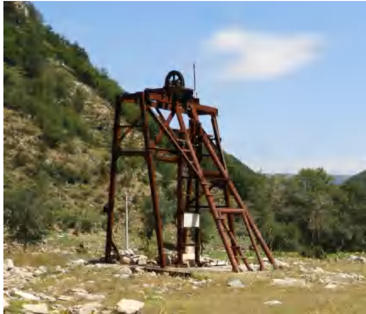
照片 4-4 废弃竖井临时封堵效果
