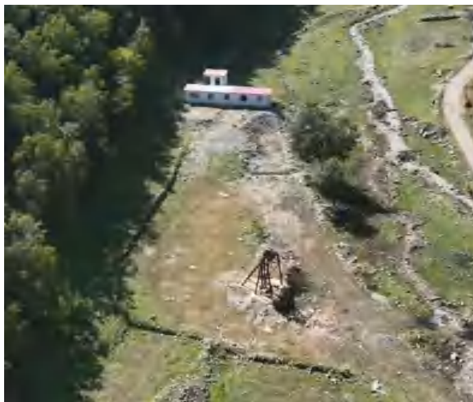
照片3-10 废弃竖井工业场地
