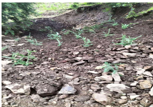
照片2-5 探槽治理照片
