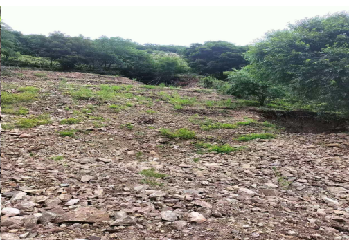
照片2-6 民采坑治理照片
