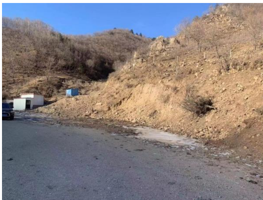
照片4-27 矿区道路
