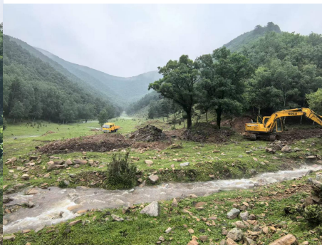
照片2-8 废石场治理照片
