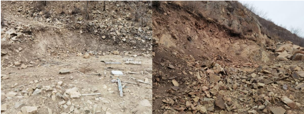
照片 4-9 钻机平台 1
