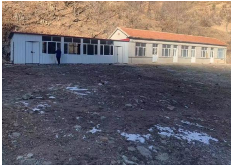
照片2-1 废石场平台零散废石清理
