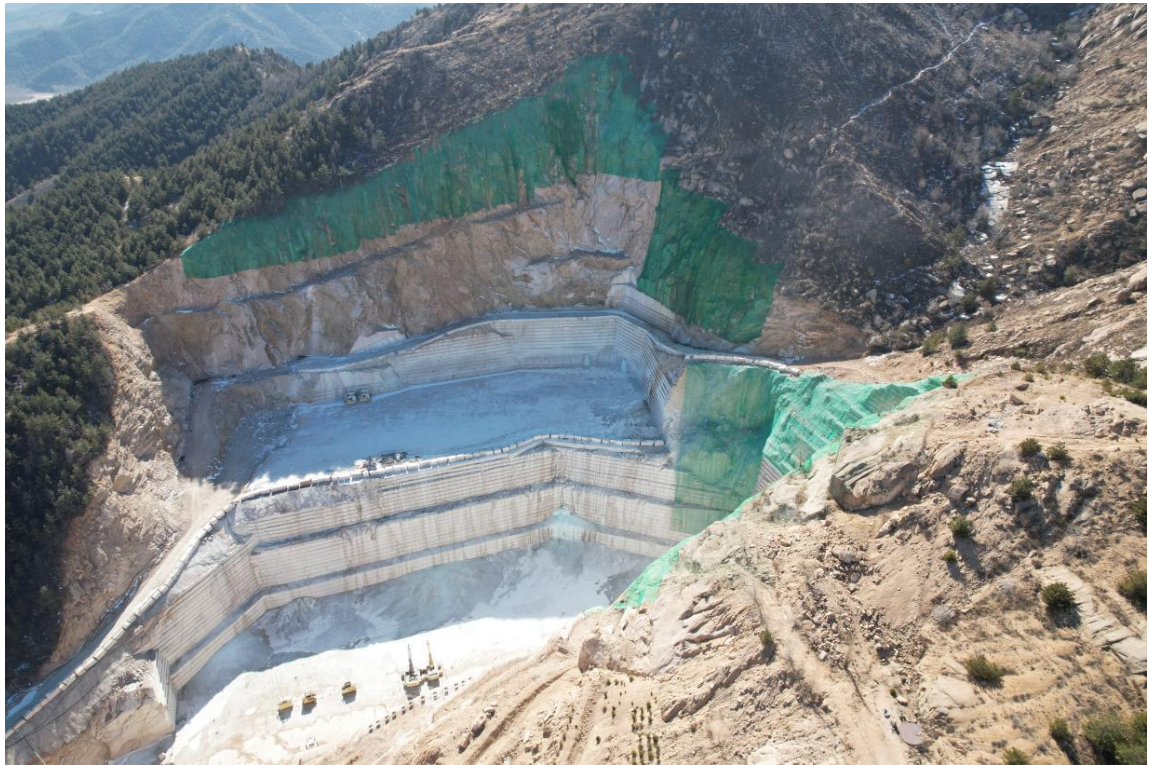
照片 1-2 露天采坑
