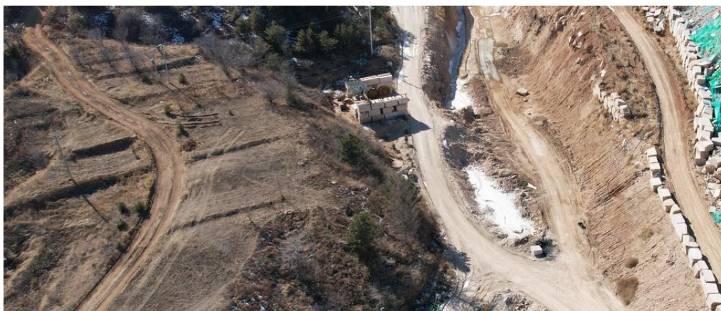
照片 1-19 矿区道路
