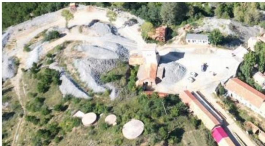
照片4-1 竖井工业场地
