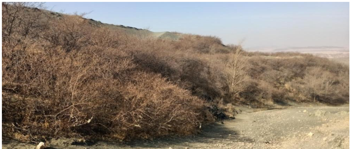
照片 4-7 1#尾矿库尾矿坝
