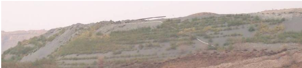
照片 2-1 1#尾矿库边坡治理
