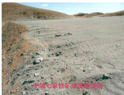
照片 2-5 排渣场堆顶部整平
