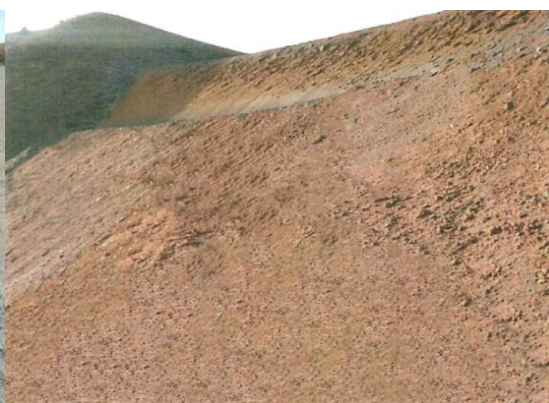
照片 2-6 排渣场坡面治理
