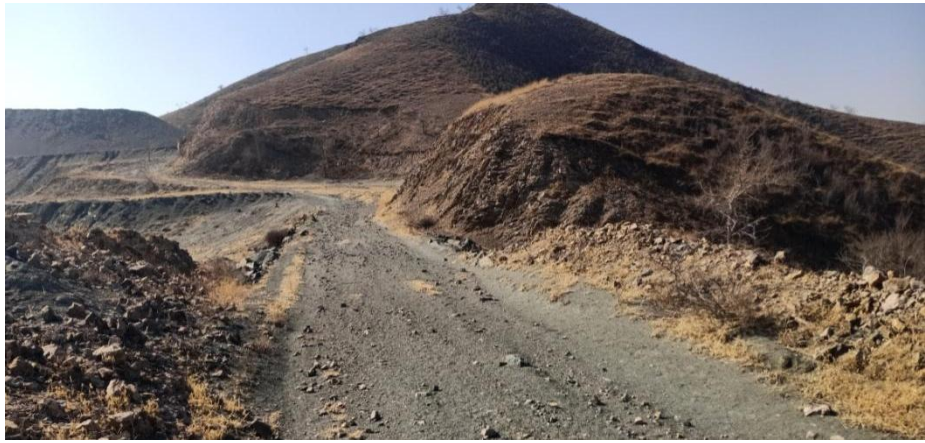
照片 4-12 矿区道路（切坡路段）
