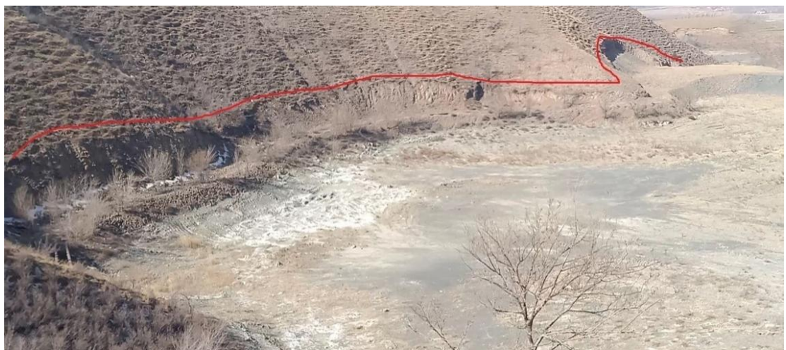
照片 4-8 1#尾矿库南部切坡
