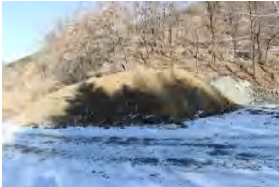
照片 3-97 成品堆放区临时堆放渣土堆
