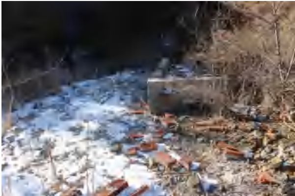
照片 3-22 竖井工业场地 6 废弃建筑基础
