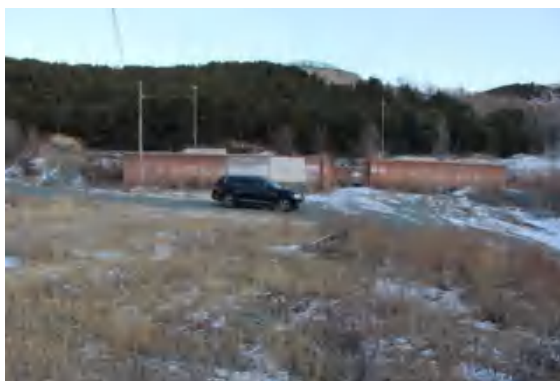
照片 3-99 炸药雷管库
