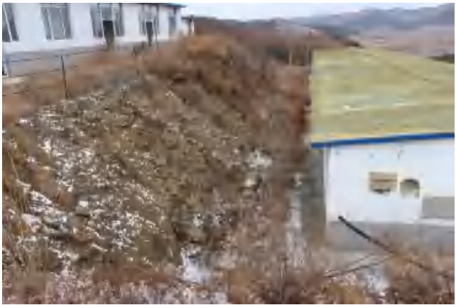
照片 3-118 办公生活区 807m 平台切坡
