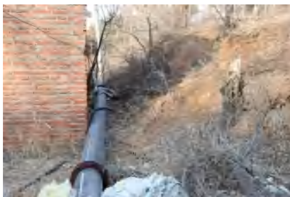
照片 3-111 选厂值班室切坡
