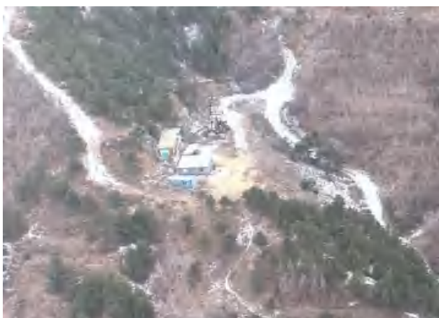
照片 3-3 竖井工业场地 1 俯视照片
