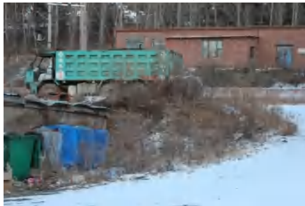
照片 3-108 选厂值班室
