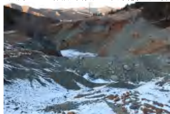
照片 3-95 成品堆放区出入沟边坡
