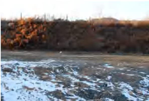
照片 3-115 沉淀池坡面
