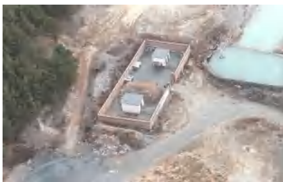
照片 3-101 炸药雷管库俯视照片
