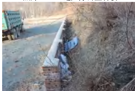
照片 3-110 选厂车场切坡
