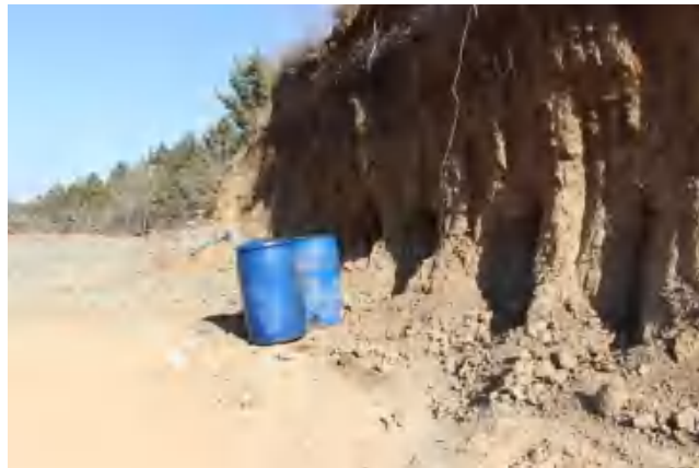
照片 3-90 干选厂内矿石堆放区切坡
