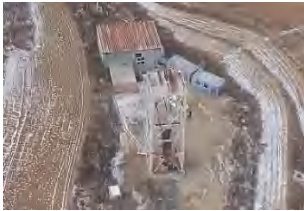
照片 3-12 竖井工业场地 3 俯视照片
