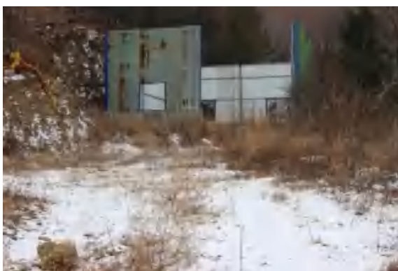
照片 3-17 竖井工业场地 5 场地及切坡
