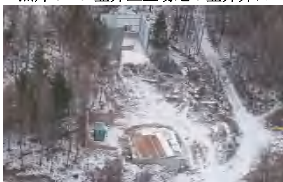
照片 3-19 竖井工业场地 5 俯视图照片
