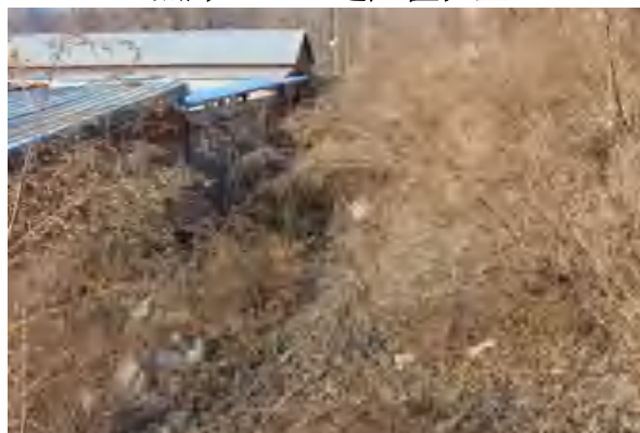
照片 3-109 选厂办公室切坡
