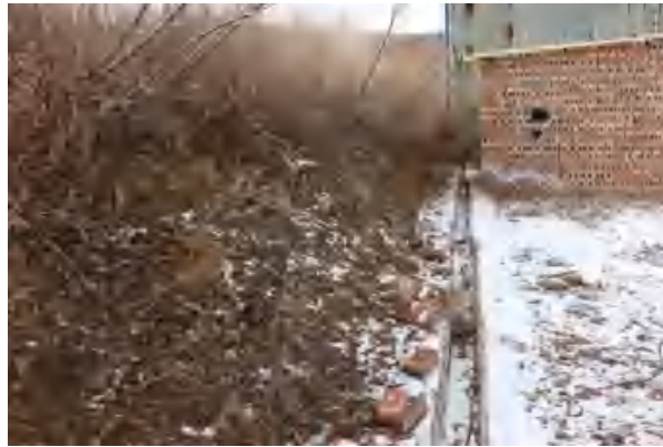
照片 3-11 竖井工业场地 3 切坡及排水沟
