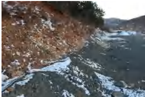
照片 3-104 选厂上料场地 722m 平台切坡
