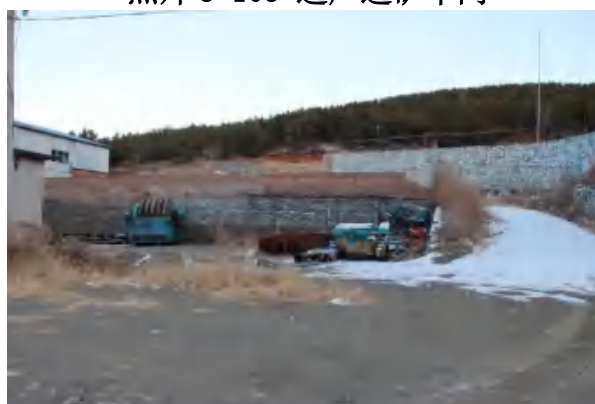
照片 3-106 选厂选矿车间浆砌石挡墙
