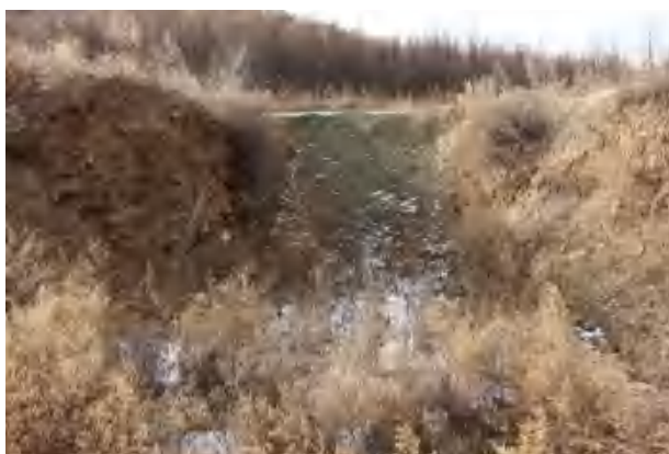
照片 3-15 竖井工业场地 4 排渣道
