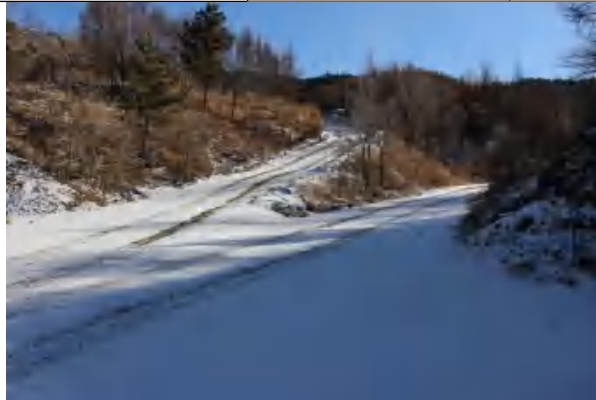
照片 3-121 矿建区域矿区道路
