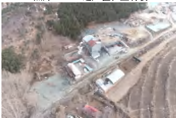
照片 3-112 选厂俯视全景照片
