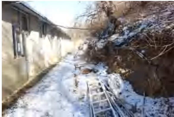
照片 3-5 竖井工业场地 2 场地切坡
