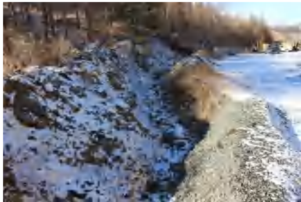
照片 3-6 竖井工业场地 2 截洪沟
