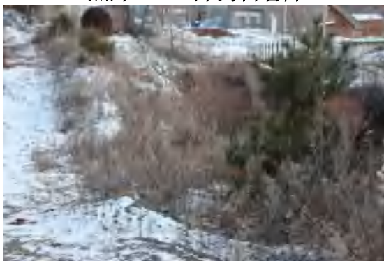
照片 3-100 炸药雷管库切坡
