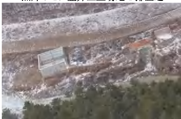
照片 3-16 竖井工业场地 4 俯视照片
