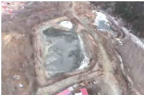
照片 3-116 沉淀池俯视全景照片
