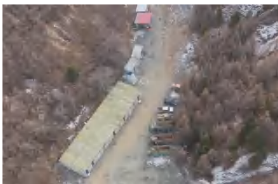
照片 3-8 竖井工业场地 2 俯视照片
