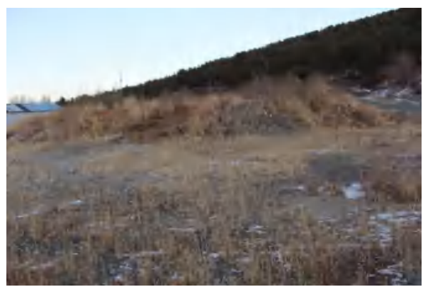
照片 3-102 选厂上料场地 720m 平台及切坡
