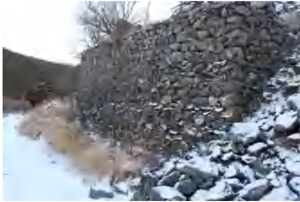
照片 3-92 干选加工区干砌石挡墙
