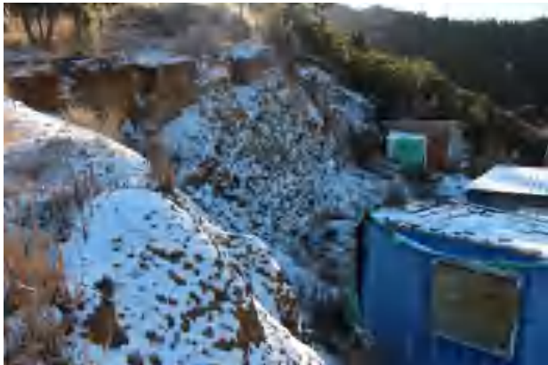
照片3-2 竖井工业场地1切坡
