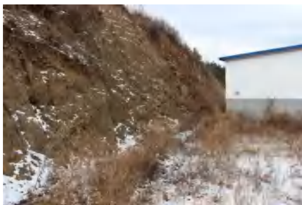
照片 3-119 办公生活区 809m 平台切坡
