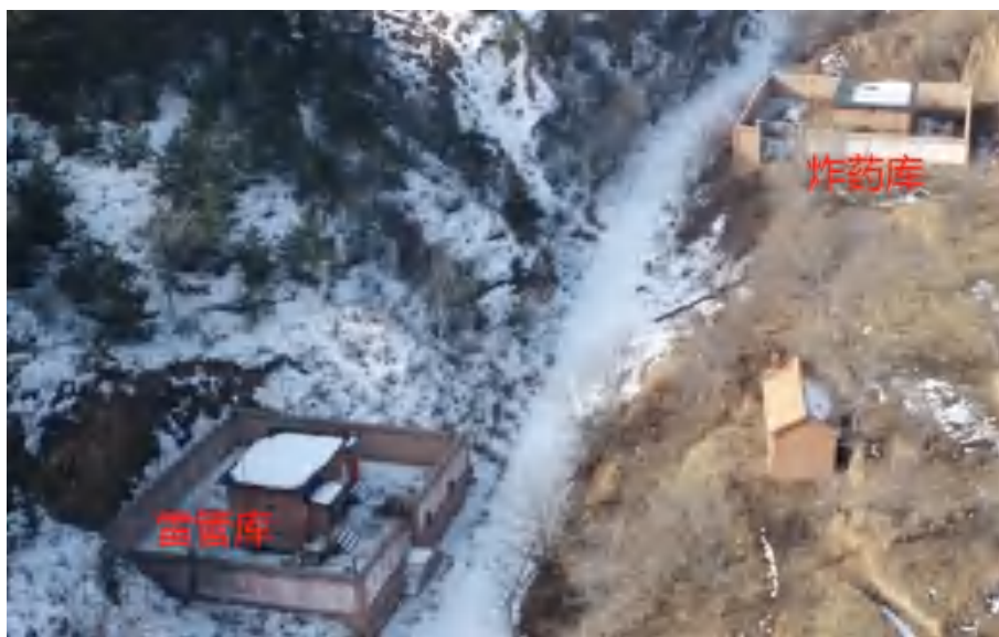
照片 4-34 炸药库及雷管库
