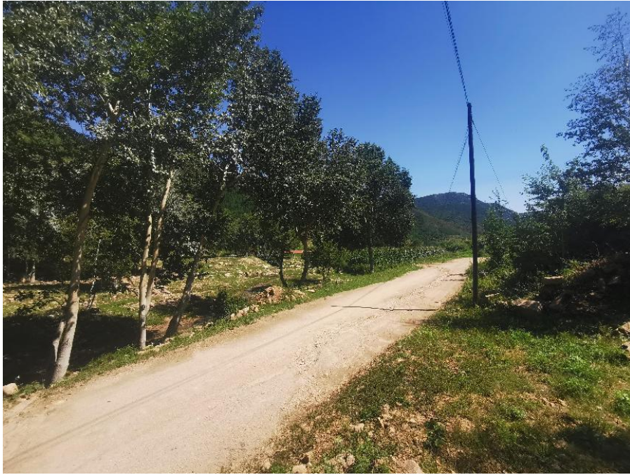
照片3-3 矿区道路
